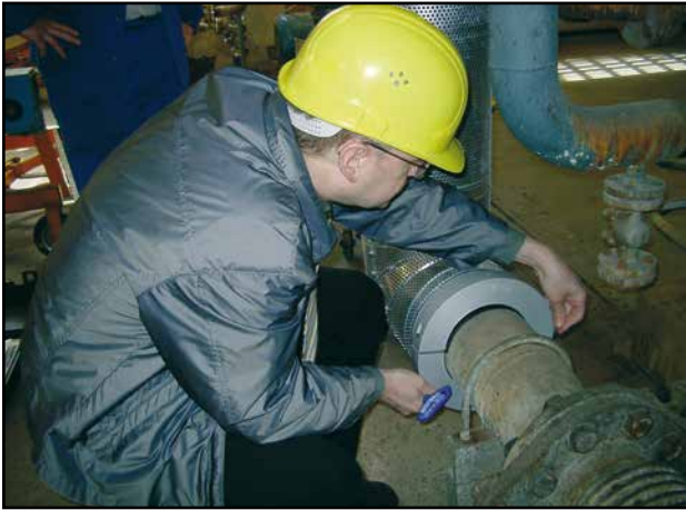
Montage eines 8" Rings an einer Industrieanlage
